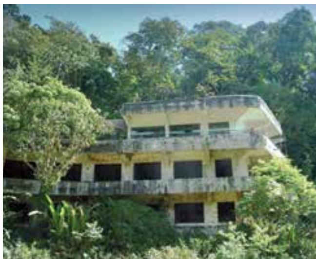
Ruina Biologickej stanice Rancho Grande na hrebeni Pobrežného pohoria nad Choroni. LD
