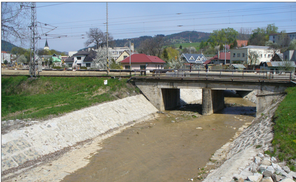
Obr. 30: Tvrdé opevnenie celého koryta (potok v Lipanoch). Foto: Eva Bulánková
